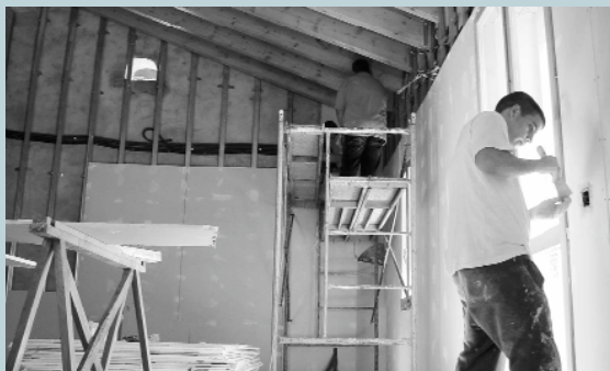
El alumnado de la Casa de Oficios es el encargado de la fase final de la rehabilitación de la Alquería de Moret
