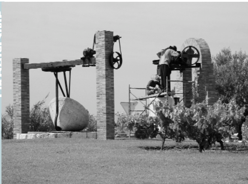
Trabajos de mantenimiento de la Rotonda de l'Almàssera
